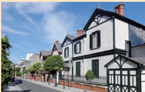
神戸北野の西洋館群(重伝建地区) [撮影：米山淳一]
